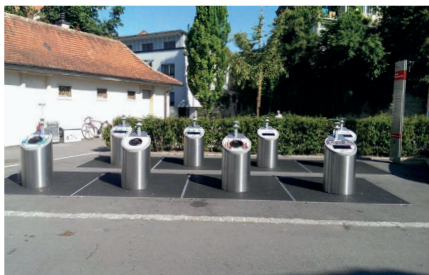
Beispiel einer Quartierentsorgungsstelle
